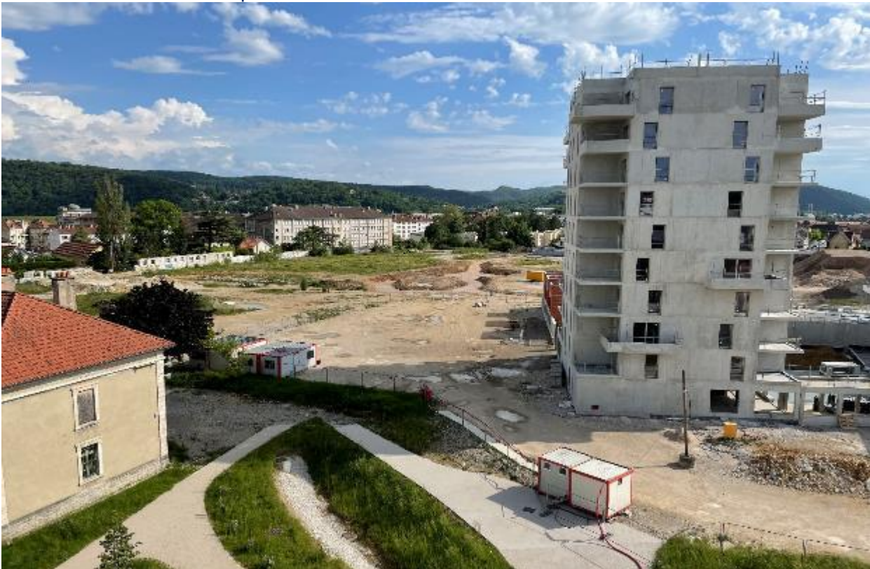
Vue sur construction lot 3 et phase 2 non réalisée - 2021
