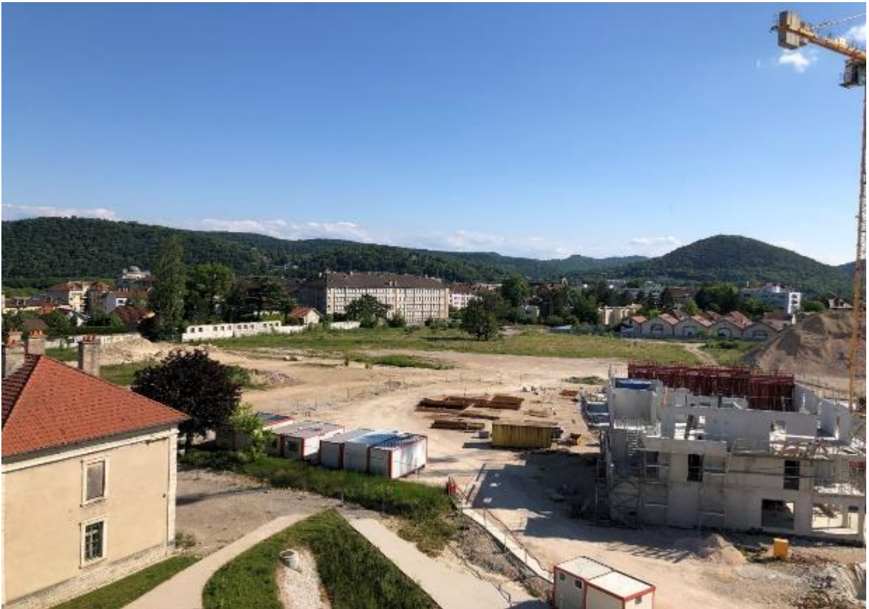
Vue sur construction lot 3 et phase 2 non réalisée - 2020
