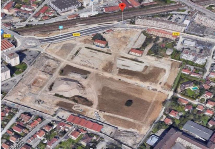
Vue aérienne après démolition
