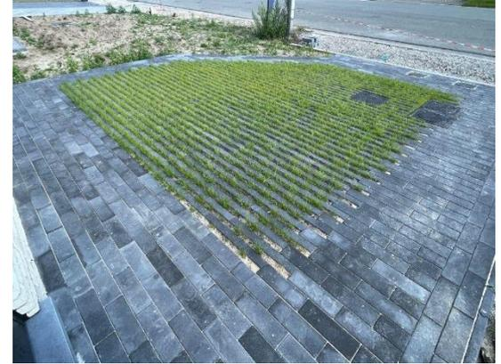
Pavés à joints perméables
