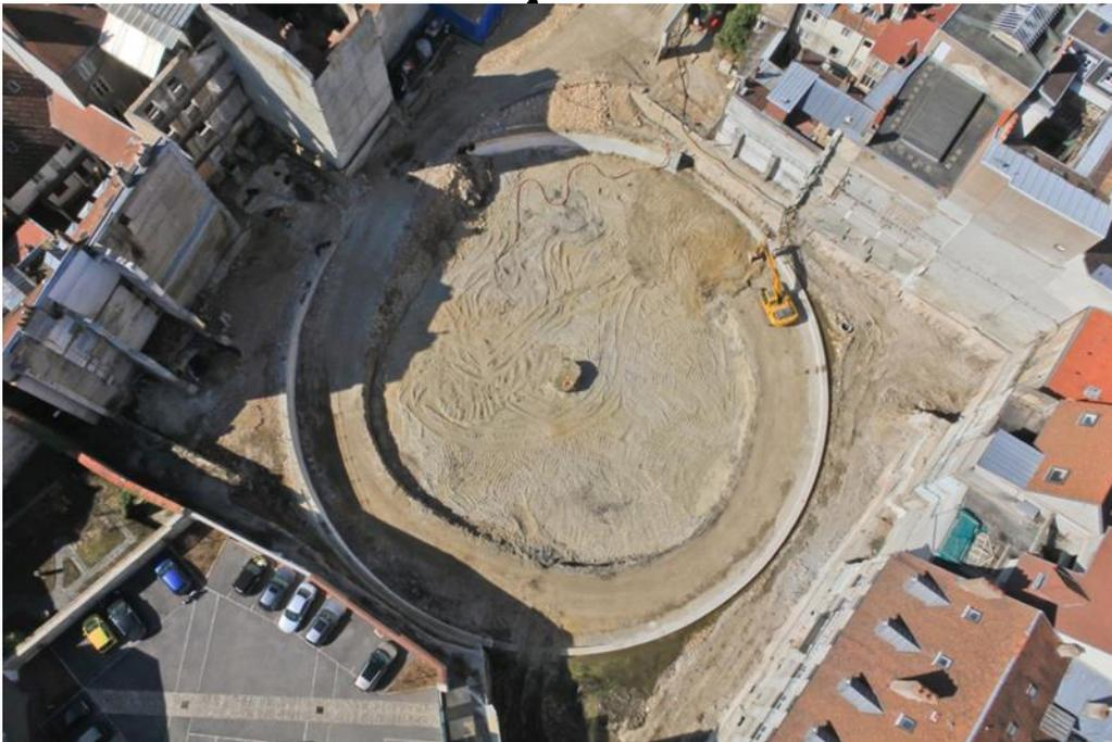
Afin de réaliser le parking, il a été nécessaire de réaliser les fouilles archéologiques sur 10 mètres de profondeur puis de terrasser la roche calcaire sur 10 mètres de profondeur également. Le choix s'est porté sur la méthode du micro-minage.
