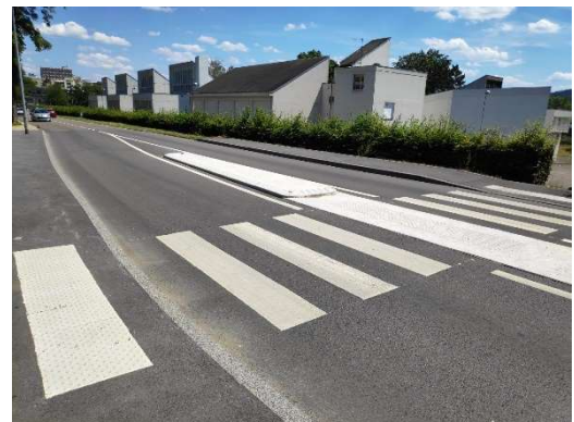
Route de Gray Passage Piéton
