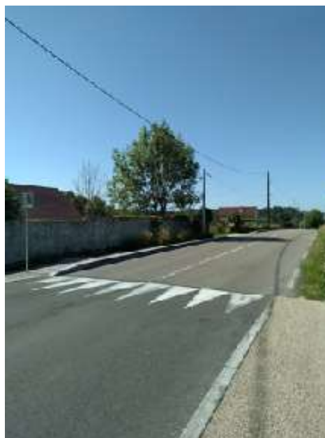
Création d'un aménagement de sécurité (cheminement modes doux en bordure de la RD486), et plateau surélevé permettant de ralentir les vitesses en entrée de ville.
