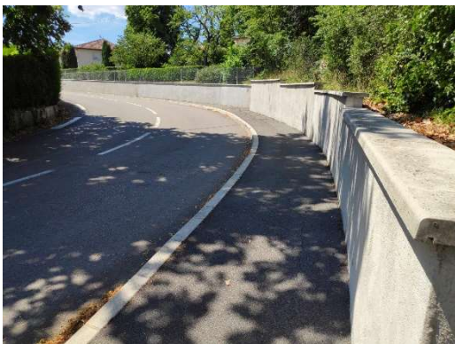
Rue du Sanatorium : Trottoir
