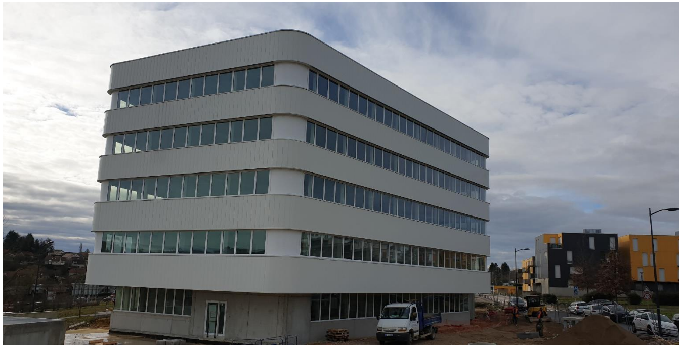
BIO INNOVATION en chantier
