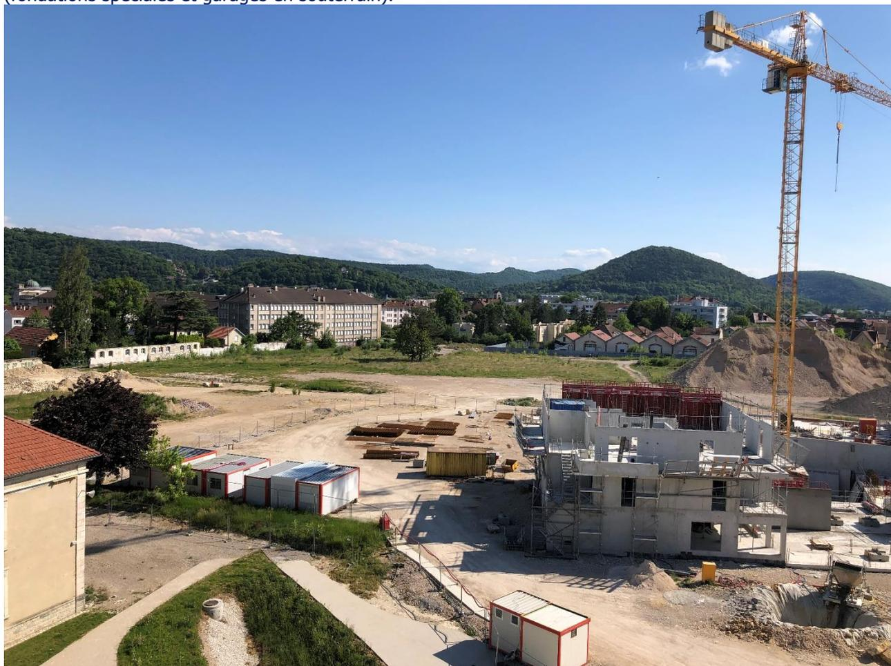
Pour anticiper l'arrivée des premiers habitants, les travaux d'aménagement et de finition aux abords des lots 1 et 5 se sont accélérés pendant les 2 premiers trimestres. Ainsi les enrobés, bétons désactivés et autres stabilisés formant les voies d'accès et les liaisons douces parcourant le projet ont été réalisés.
