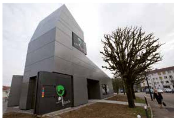
Le pôle des Tilleuls, bâtiment 100 % renouvelable.
