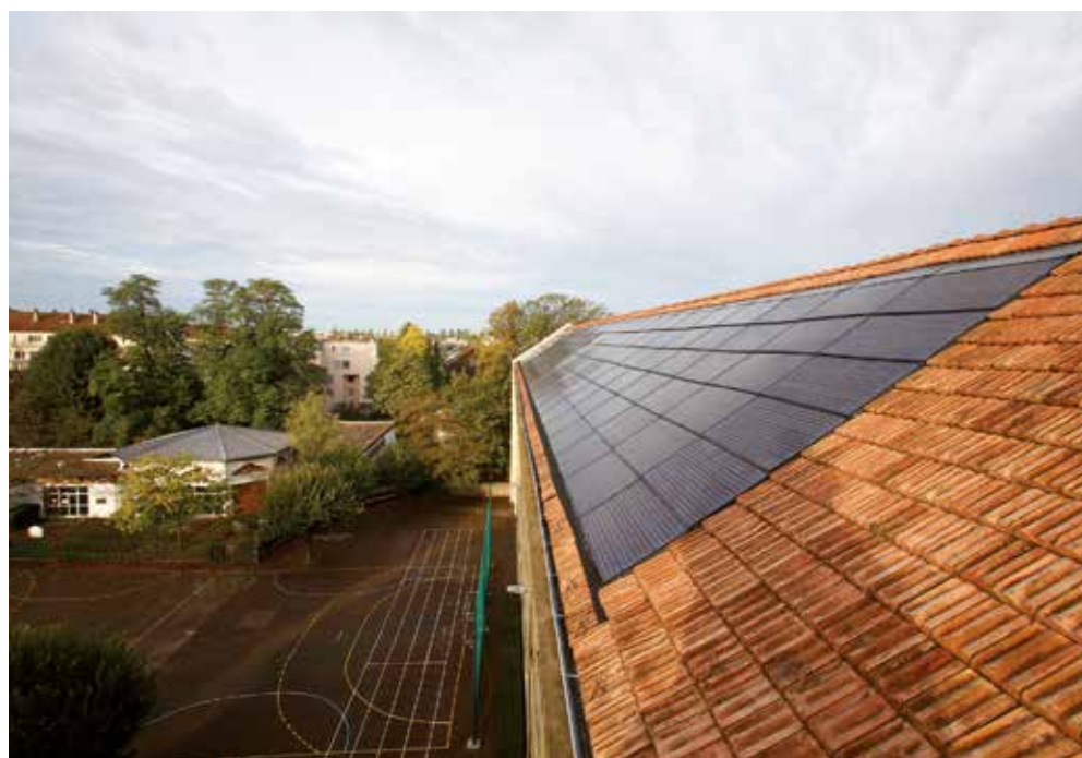
Panneaux solaires sur le toit de l'école Vieilles Perrières.
