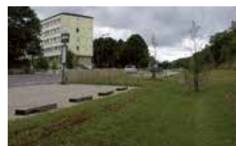
Nouvel aspect de la rue Laplace après travaux.
