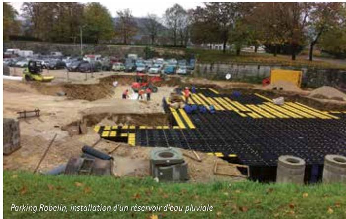
Parking Robelin, installation d'un réservoir d'eau pluviale
