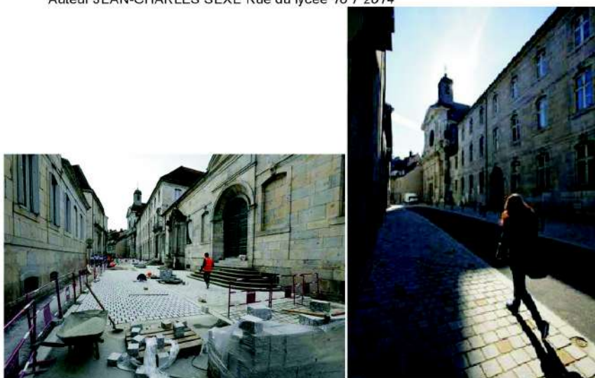
Rue du Lycée terminée
