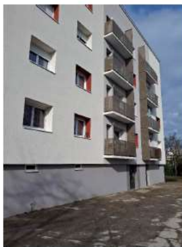
Besançon chemin des Montarmots 8 logements réhabilités Livraison août 2025 Passage d'une étiquette F à C
