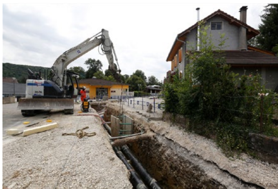
Travaux réseau de chaleur à Novillars - © JC SEXE
