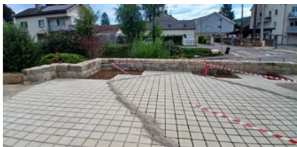
Requalification de la rue de la gare à Roche-lez-Beaupré
