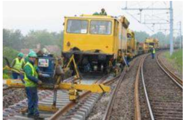
Longs Rails soudés sur traverses béton
