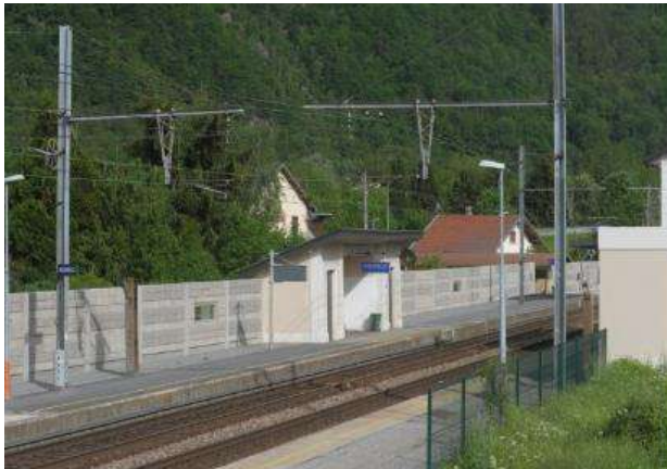
Exemples d'écrans acoustiques à Aiguebelle et Moirans
