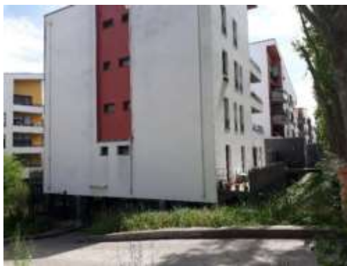
Exemple de construction adaptée en zone inondable
