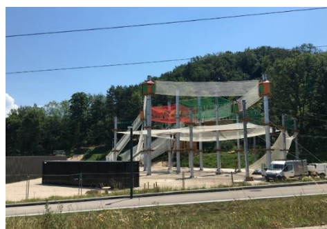
4 : Installations extérieures du 1055
