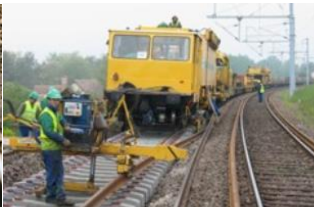
Longs Rails soudés sur traverses béton
