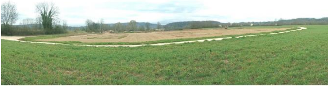
Parking paysager en cours de construction
