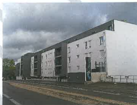
Besançon 64 logements neufs livrés en septembre 2023 Rue de Dole
