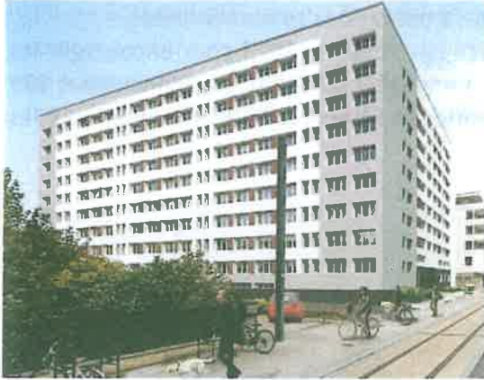
Besançon Avenue Fontaine Argent 97 logements en cours de réhabilitation Livraison mars 2024
