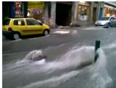
Figure 141 – Orage 26 juin 2009 – 99 rue Battant, Besançon
