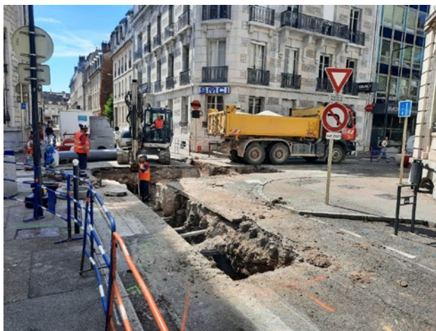
Pose du nouveau réseau d'eaux pluviales rue Gambetta
