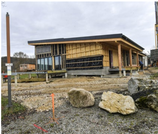
Rénovation de la base d'Osselle
