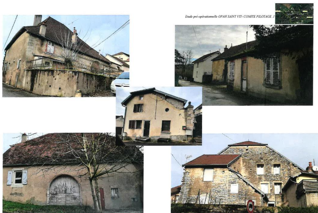
Façades de Saint Vit, source : comité de pilotage étude pré opérationnelle OPAH
