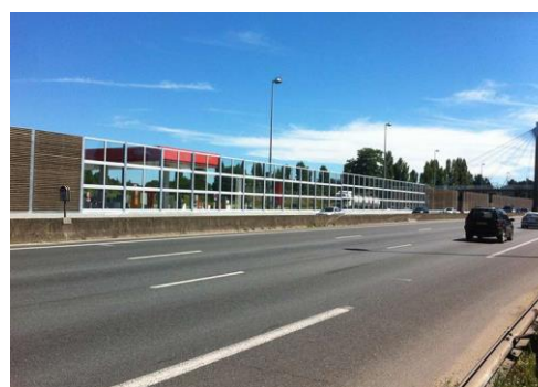
Figure 5 – Ecran absorbant (source : www.artefac-bonnasabla.com ) et écran réfléchissant transparent (source : www.ecib-bruit.com )
