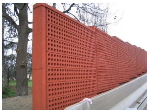
Figure 5 – Ecran absorbant (source : www.artefac-bonnasabla.com ) et écran réfléchissant transparent (source : www.ecib-bruit.com )
