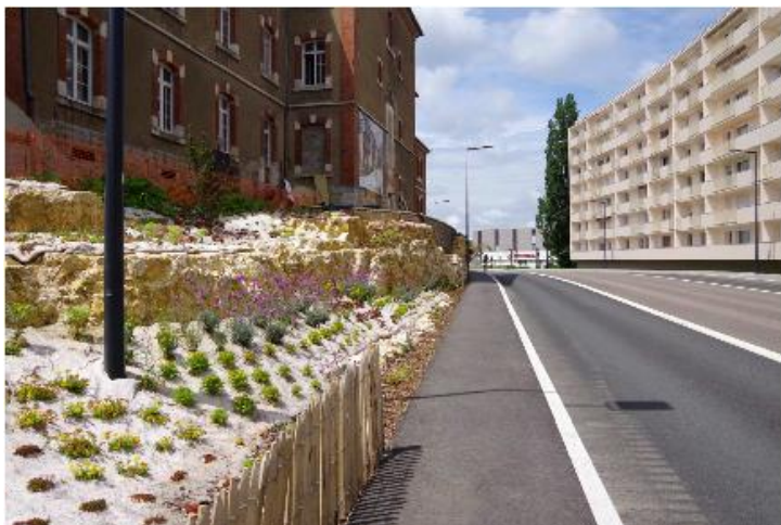
TCSP – Trottoir rue Voirin
