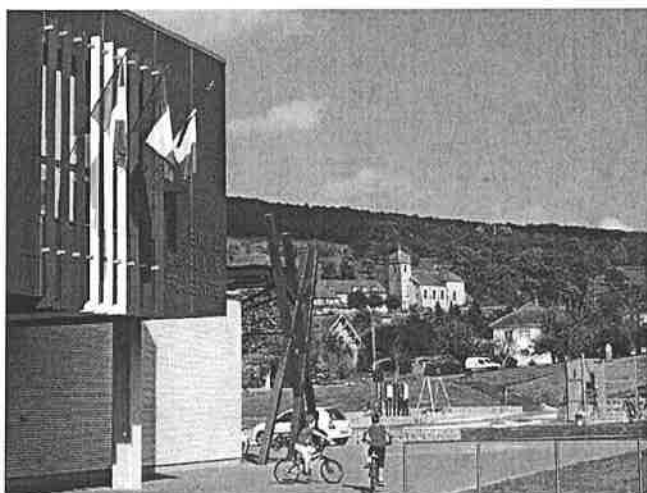
La nouvelle mairie d'Amagney et le centre bourg – Crédit : Donzé architecte
