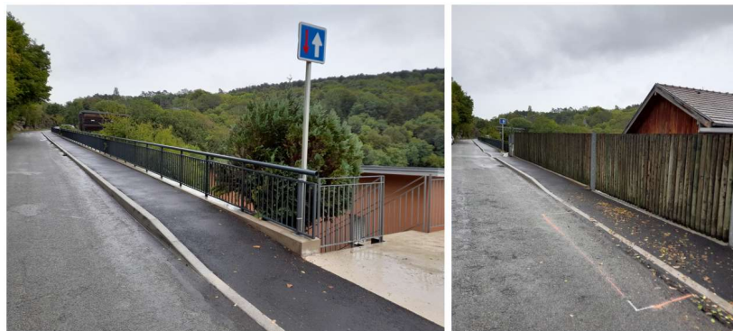
Chemin du Fort Bregille, création d'un trottoir
