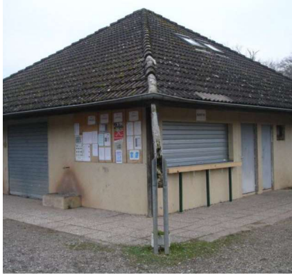
Les vestiaires du stade avant travaux... Photo ER
