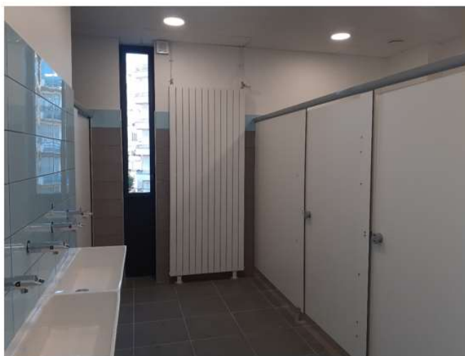
Création WC PMR et zone refuge
