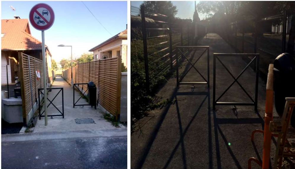
Combe Sarrogosse – Création d'une liaison piétonne
