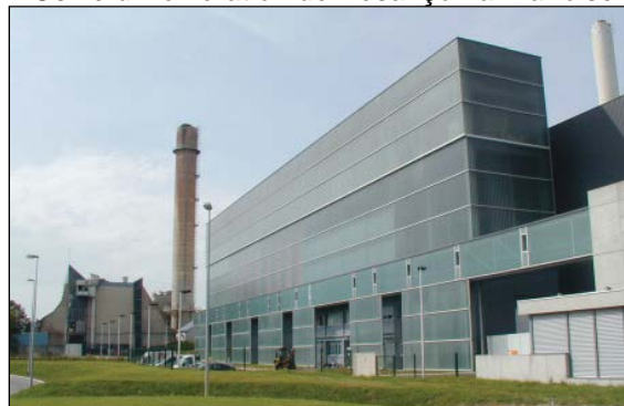
Usine d'incinération de Besançon à Planoise.
