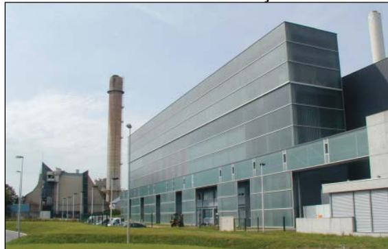
Cette usine, construite en 1971, était initialement équipée de deux lignes (n°1 et n°2) d'une capacité horaire de 2 tonnes chacune, soit une capacité annuelle de 32 000 tonnes.
